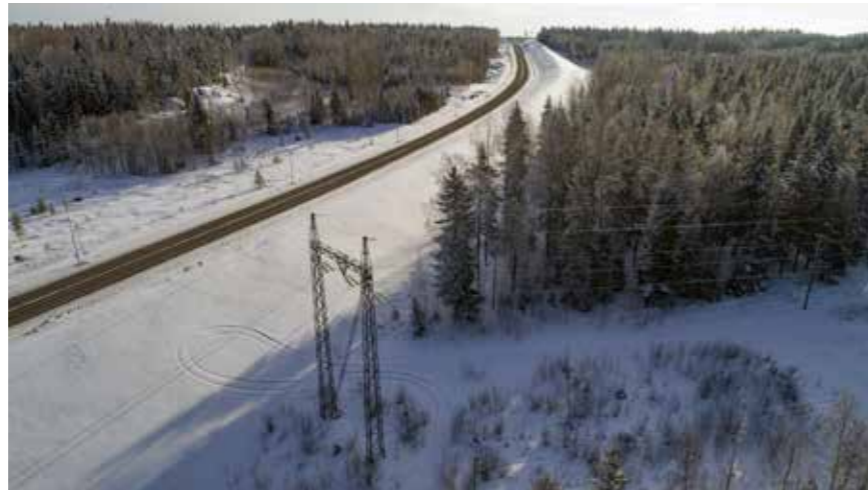
Klaukkalan uusi ohikulkutie vaati sähkötöitä.
